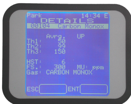
Figura 42) Dettagli configurazione rilevatore gas
